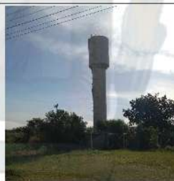
Reservatório Elevado Vila Adema, Pr
